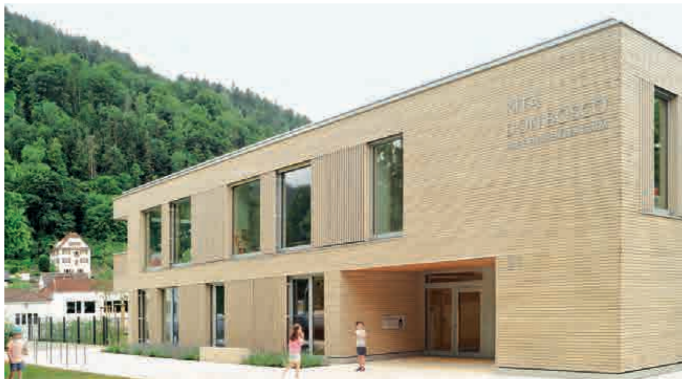
Über 70 Kinder zogen in das neue Gebäude des Familienzentrums Don Bosco ein und haben sich inzwischen bestens eingewöhnt
