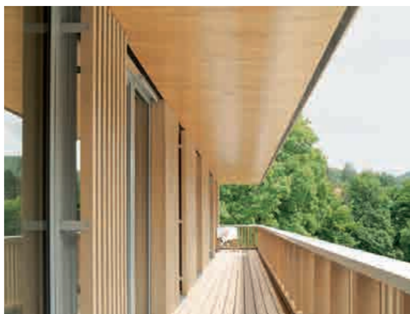
Die konsequente Materialwahl Holz findet sich in der Außenfassade genauso wie im Inneren an Wänden, Böden und Einrichtung und schafft so einen wohltuenden Raum für die Kinder
