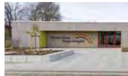
Inklusives Kinderhaus Regenbogen, Kießlegg Bauherrschafft: Kath. Kirchengemeinde St. Gallus und Ulrich, Kießlegg mit Stiftung KBZO, Weingartengäu Architekten: roterpunkt architekten, Kistler, Sohn, Waizenegger Fertigstellung: 2019
